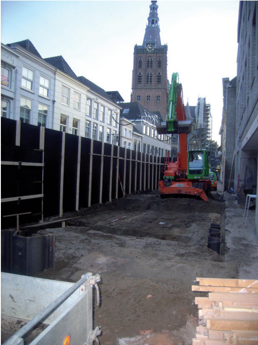
Afb. 1.1 Het onderzoeksgebied in de Kerkstraat, voor het postkantoor. Foto genomen richting het oosten.
