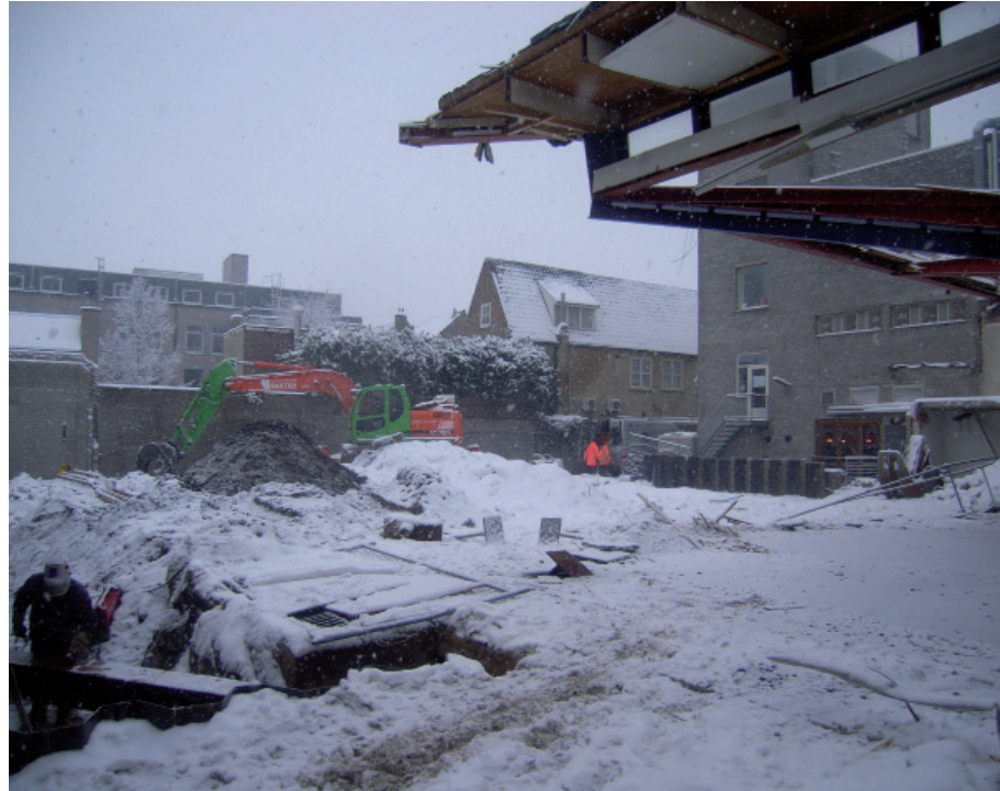
Afb. 1.3 Het onderzoeksgebied op het achterterrein. De foto's zijn vaak erg donker; dit komt door het nogal extreme weer (het regende en sneeuwde bijna de gehele opgraving). Foto genomen richting het zuidwesten.
